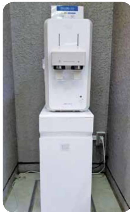
設置されたウォータースタンド (冷水・常温水を給水できます)
